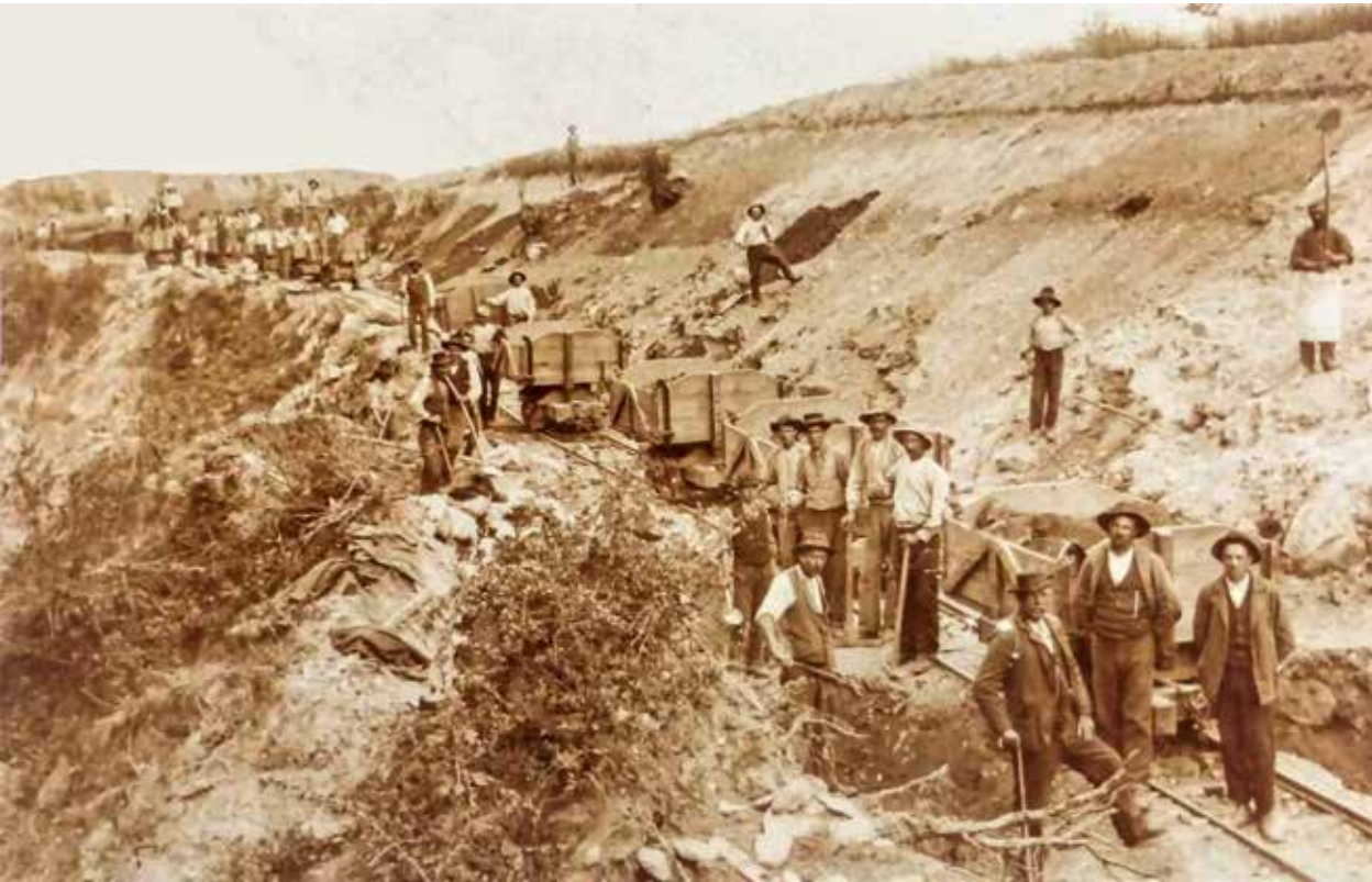
Deicharbeiten entlang der Etsch im Trentino.
