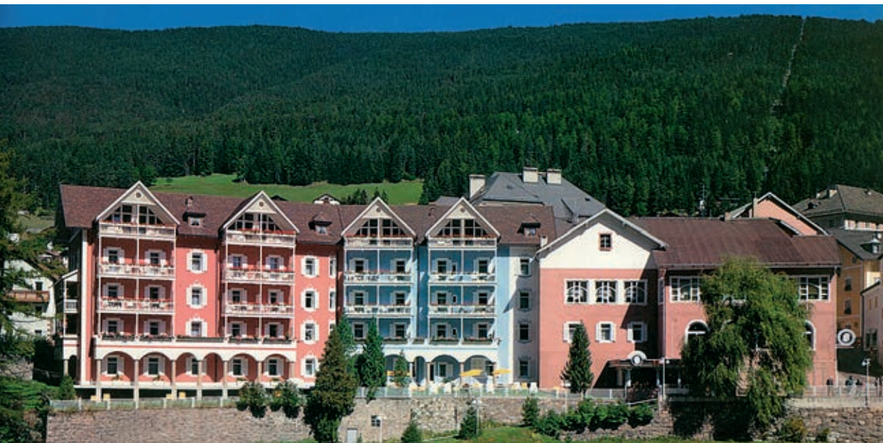
Vor dem Neubau 2001
