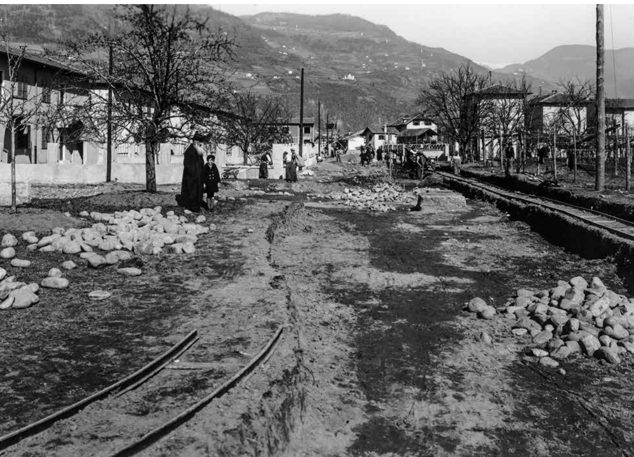
Via Palermo in costruzione, agosto 1940. ASCBz Fondo Fotografico LLPP foto n. 2096
