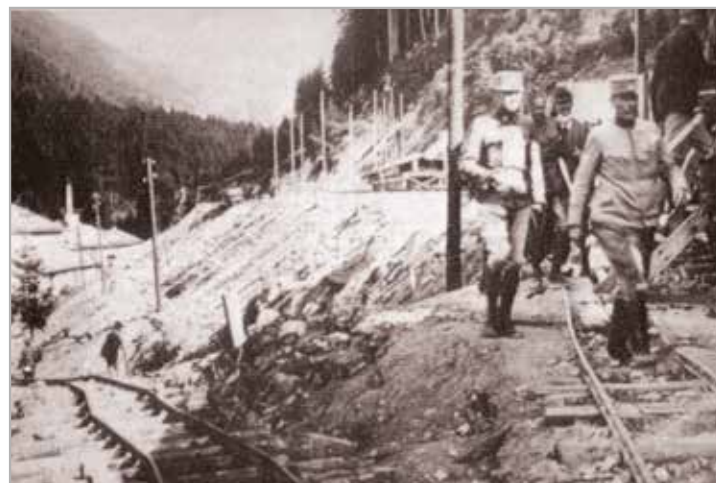
Kaltenbrunn, 1916. Inspektion der Betriebsleitung an einer Baustelle in Bahnhofsnähe
