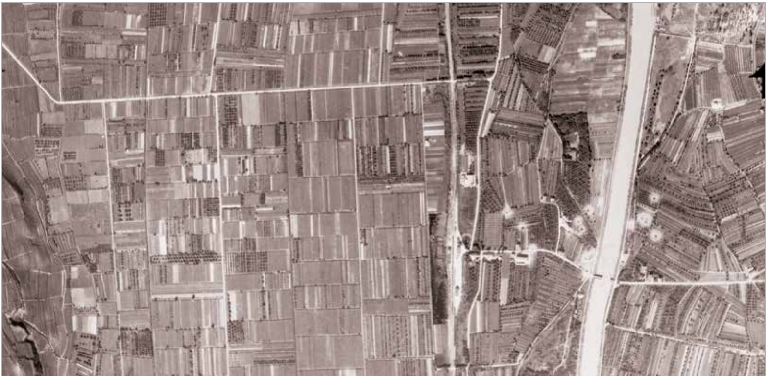
Neumarkt, 9. September 1944 (RAF-Luftaufnahme). Auf der Bildmitte die Straßenbrücke, die den Ort Neumarkt mit der Bahnstation verband. Sie war bei einem Luftangriff am 4. September 1944 halb zerstört worden, und auch die Bahnlinie Auer–Lavis–Gardolo erlitt schwere Schäden. Rechts und links des Flusses sind etliche Bombentrichter zu erkennen.
