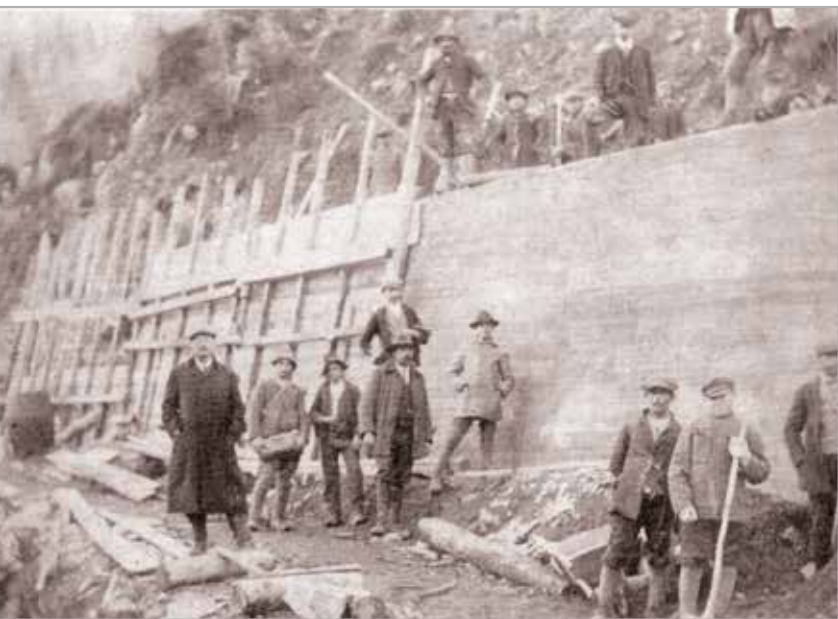
Pausa, 1916. Bau einer Stützmauer aus Zement
