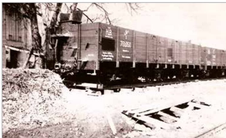
Bahnhof Auer, 20. März 1917. Güterwagen der Heeresbahn auf einem Abstellgleis. Ähnliche Schmalspurwaggons wurden zum Schottertransport von den zwischen Auer und Branzoll gelegenen Porphybrüchen auf einem provisorischen Gleis zum Bahnhof Auer benutzt. Heutzutage müssten für derlei Schottermengen mindestens 18.000 LKW-Fahrten berechnet werden.
