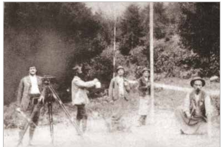
Fleimstalbahn, 1916. Techniker bei Vermessungsarbeiten der neuen Trasse am linken Avisioufer
