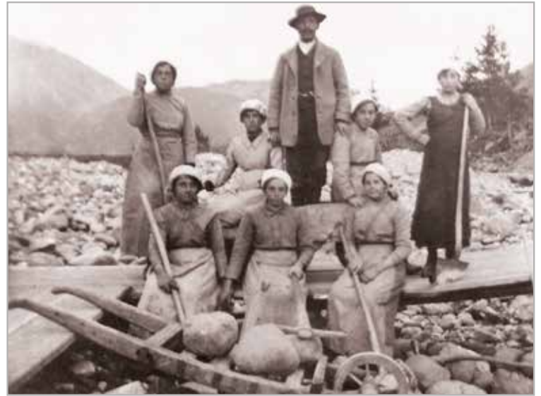
Roda di Ziano, 1916. Beim Bahnbau waren auch viele Frauen (Einheimische und Slawinnen) beschäftigt, die vor allem bei der Anlage der Rampen und der Bahndämme eingesetzt wurden. Als Arbeitsgeräte hatten sie nichts anderes als eine Schaufel und einen Schubkarren. Mitte Mai 1917 richtete eine verheerende Überschwemmung im Osttiroler Drautal an der Bahnlinie Lienz–Spittal schwere Schäden an. Da sie wegen ihrer Nähe zur Front und des Nachschubs von lebenswichtiger Bedeutung war, wurden drei Eisenbahnerkompanien und 19 russische Soldatenkompanien (insgesamt rund 4000 Mann) aus dem Fleimstal abgezogen und in diese Gegend geschickt. Um diesen Verlust an Arbeitskräften gutzumachen, warb das Militärkommando der Fleimstalbahn junge Einheimische beiderlei Geschlechts an, denen sich somit auch die Gelegenheit bot, sich in dieser schweren Zeit ihren Lebensunterhalt zu verdienen.
