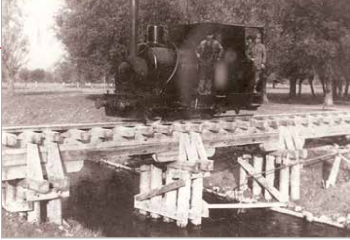
Auer, 15. Oktober 1916. Eine kleine, beim Bau der Fleimstalbahn verwendete Dampflok (sie wurde auch als caffettiera bezeichnet, als „Kaffeemaschine“) bei einer Belastungsprobe auf der provisorischen Brücke, auf der die mit Porphyrscutt beladenen Güterzüge den Großen Branzoller Graben in der Nähe der Station Auer überwinden. Zur Gruppe der „kleinen Maschinen“ gehörten auch bis zu zehn von anderen k. u. k. Bahnen stammende Lokomotiven, darunter auch eine der sieben Loks (die Nr. 4151) der Grödner Bahn.
