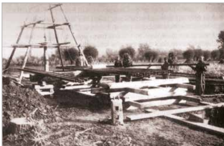
Auer, 1916. Zur Befestigung des Geländes wurden zahlreiche Pfähle in den Boden getrieben, auf denen dann die Gebäude errichtet wurden.
