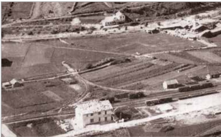
Predazzo, 1918. Das gut erkennliche Dreiecksgleis, eine Besonderheit der Fleimstalbahn, ermöglichte das Wenden der Lokomotiven. Andere Wendevorrichtungen bestanden in drehbaren Plattformen, die aber für alpine Gebiete ungeeignet waren, da sie bei Schneefällen oder sehr niedrigen Temperaturen nicht immer funktionierten. Das „Dreieckssystem“ besteht aus drei dreieckförmig angeordneten Gleisen, auf denen die Loks wenden konnten. An der Fleimstalbahn besaßen nur drei Stationen derartige Dreiecksgleise: Auer Depot, Castello di Fiemme und Predazzo.
