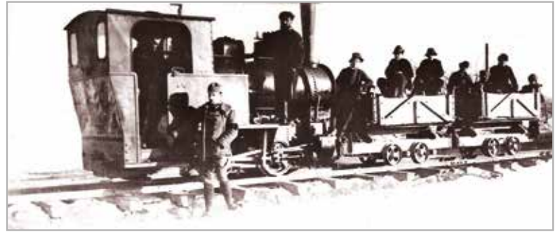
Auer, 27. Januar 1917. Ein kurzer, zum Bau der Fleimstalbahn verwendeter Zug am Streckenkilometer 0,6, nicht weit vom Ausgangsbahnhof entfernt. Vor dem Zug stehend ein k. u. k. Soldat, auf der Lokomotive der Lokführer und auf den Loren Zivilarbeiter und russische Kriegsgefangene.
