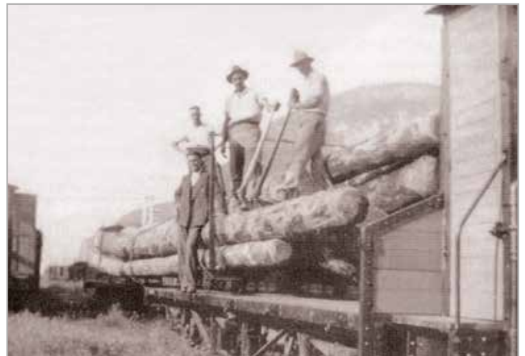
Auer, Bahnhofsdepot. Auch der Transport des aus dem Fleimstal angelieferten Holzes erlebte in den Fünzigerjahren des vorigen Jahrhunderts einen bemerkenswerten Aufschwung. Auf dem Bild die Brüder Mazzini aus Auer beim Abladen von 24 Meter langen Stämmen
