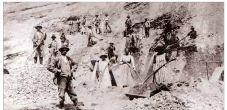
Fleimstalbahn, 1917. Männer und Frauen beim Abbau des Geländes zur Anlage des Bahndamms
