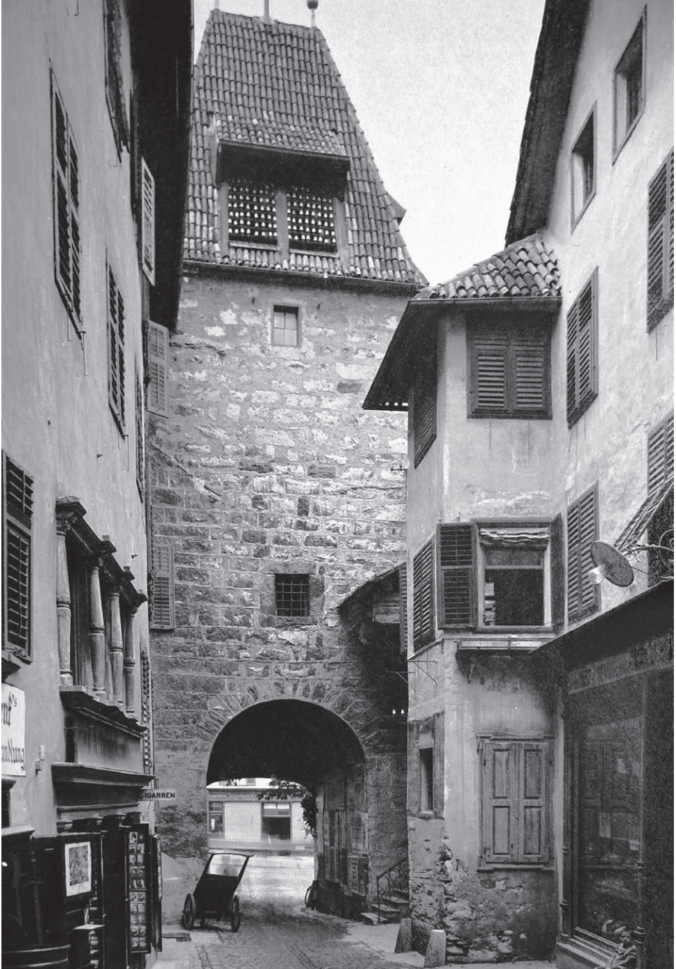
Abb. 9: Historische Ansicht des Bozner Tors um 1900 (Amt für Bau- und Kunstdenkmäler, Bildarchiv, Inv.-Nr. 17.861)
