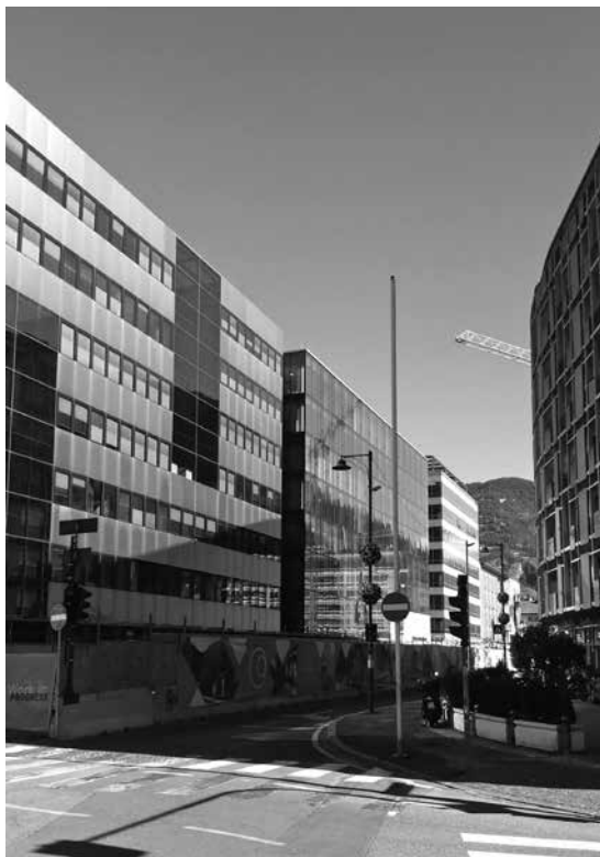
Si costruisce in via Alto Adige (2021)
